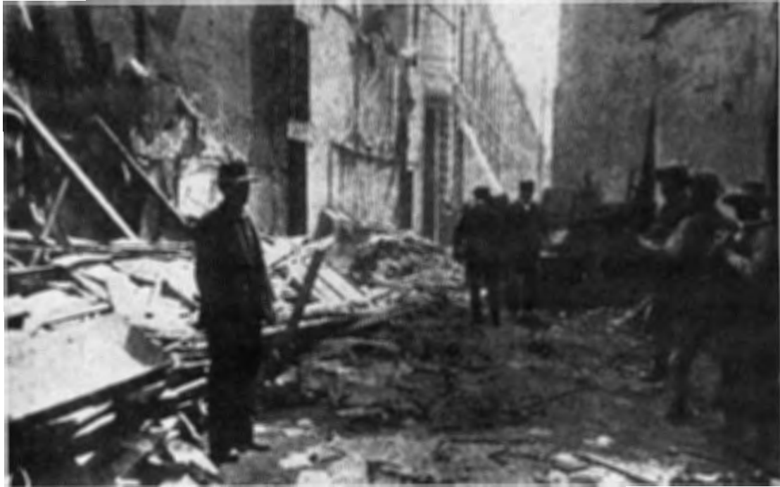
6.- El callejón Otaiza-Barrio Chino. El callejón albergaba en su interior a cerca de 500 residentes de origen chino. Dicho callejón constituía una verdadera ciudadela en cuyo interior existían viviendas, fondas, talleres artesanales, casas de juego y fumaderos de opio. El callejón se convirtió en símbolo de esta comunidad y concitó la furia de quienes se oponían racistamente a esta inmigración. En 1911 el callejón fue destruido y sus habitantes desalojados violentamente ( Variedades No. 63, Lima: 1909).
