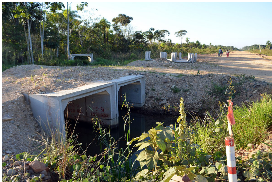
Figura 19 Fotografía de la carretera existente San Buenaventura – Ixiamas
