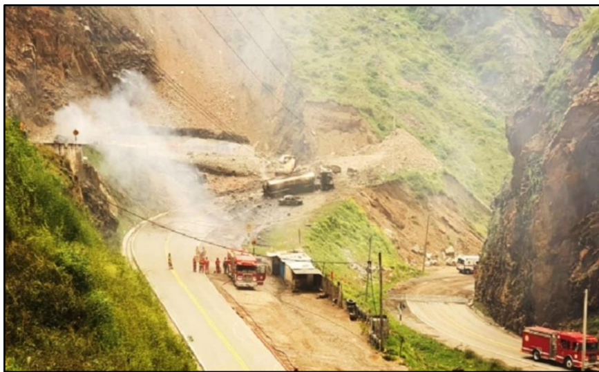
Fuente: Andina Agencia Peruana de Noticias. Nota periodística: “Carretera Central: caída de rocas provocó colisión y explosión de camiones cisterna” del 28 de marzo del 2021
