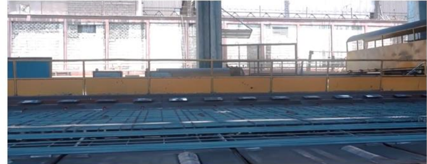
Paso 5: Proceso de laminación donde se reduce con una serie de rodillos donde aplastan la palanquilla para conseguir las barras
