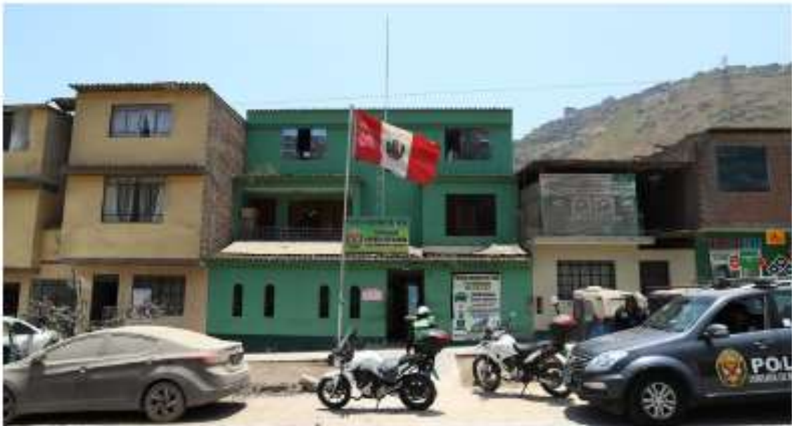
La comisaría de Nueva Esperanza funciona en una casa alquilada, debido a que su local fue declarado inhabitable y hasta hoy no es reconstruido. Esta casa no tiene las condiciones ideales para prestar el servicio policial. (Foto: El Comercio/Alessandro Currarino)
